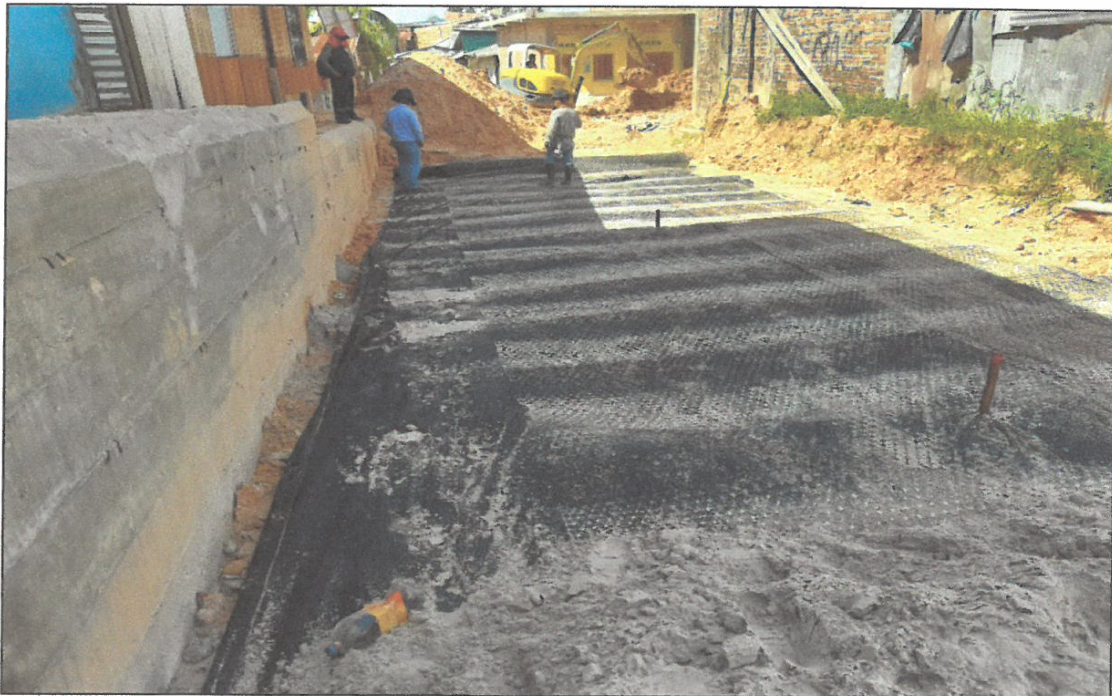
VISTA FOTOGRÁFICA N° 02 : COLOCACIÓN DE GEOMALLA Y GEOTEXTIL EN CALLE LAGUNAS TRAMO II.
