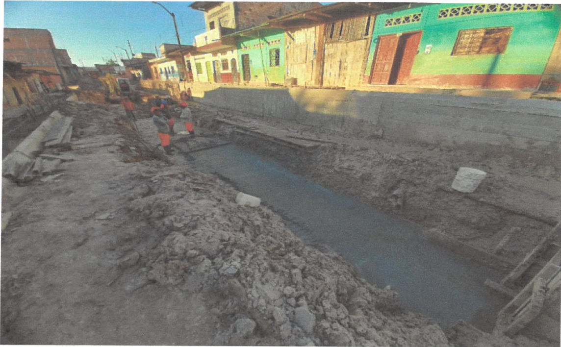
VISTA FOTOGRÁFICA N° 06: VACEADO DE LOSA DE FONDO EN CANAL DE ALCANTARILLADO EN CALLE SALAVERRY.
