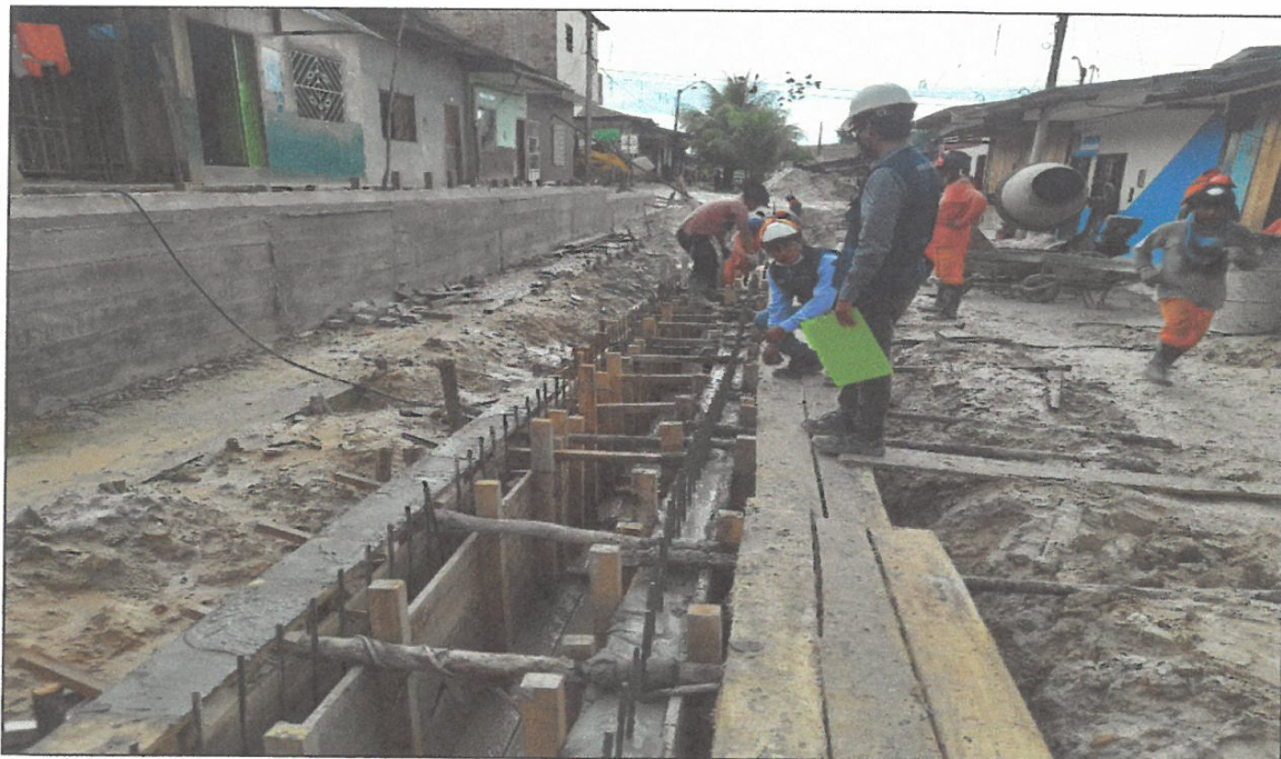
VISTA FOTOGRÁFICA N° 12: VACEADO DE MORTERO f'c= 210 kg/cm2 EN MUROS DE CANAL DE ALCANTARILLADO EN CALLE SALAVERRY.
