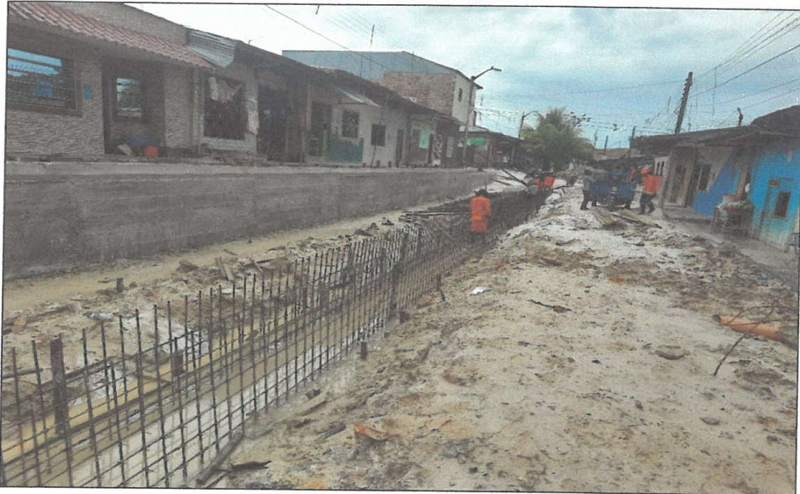
VISTA FOTOGRÁFICA N°08: ENCOFRADO EN MUROS DE CANAL DE ALCANTARILLADO EN CALLE SALAVERRY.
