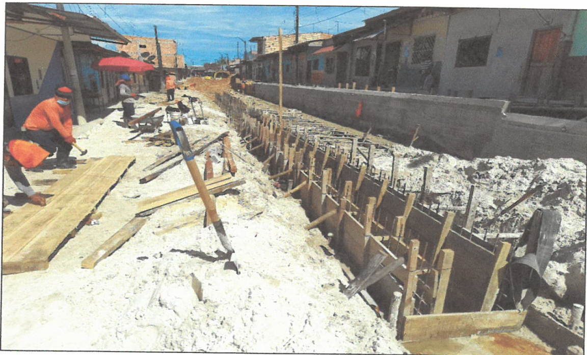
VISTA FOTOGRÁFICA N°08: ENCOFRADO EN MUROS DE CANAL DE ALCANTARILLADO EN CALLE SALAVERRY.
