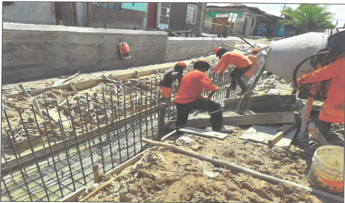
VISTA FOTOGRÁFICA N° 06: VACEADO DE LOSA DE FONDO EN CANAL DE ALCANTARILLADO EN CALLE SALAVERRY.
