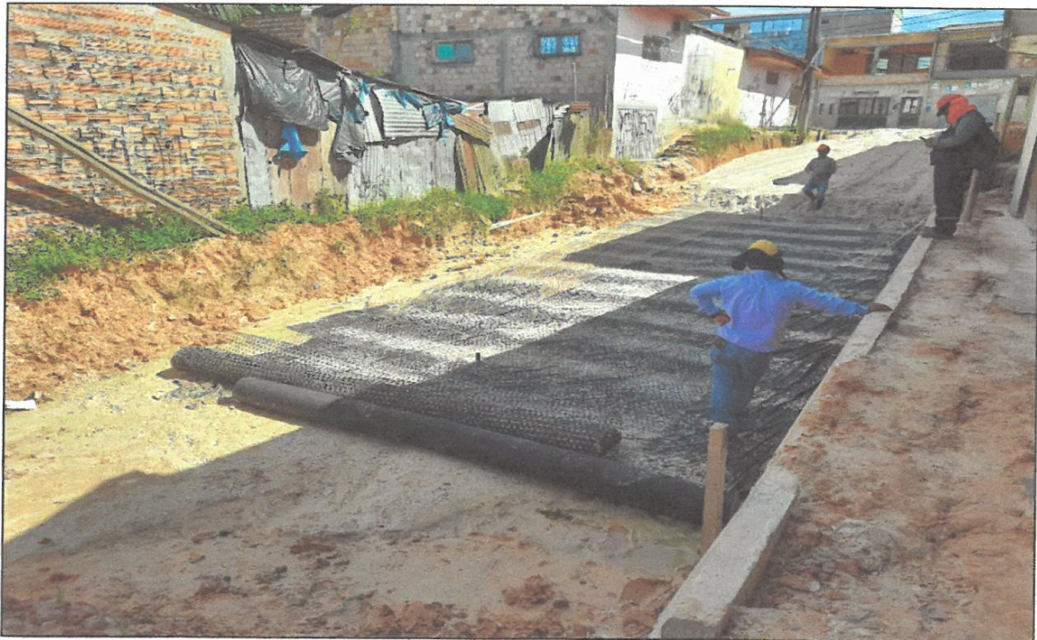
VISTA FOTOGRÁFICA N° 04: COLOCACIÓN DE GEOMALLA Y GEOTEXTIL EN CALLE LAGUNAS TRAMO II.
