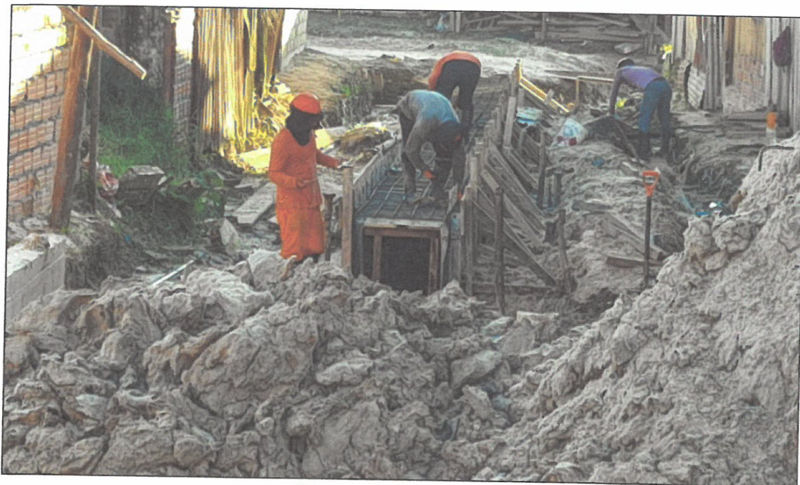
VISTA FOTOGRÁFICA N° 14: ENLUCIDO PULIDO EN MUROS DE CANAL DE ALCANTARILLADO EN CALLE SALAVERRY.
